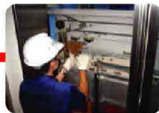
Căn chỉnh hệ thống cửa tầng, cửa cabin
