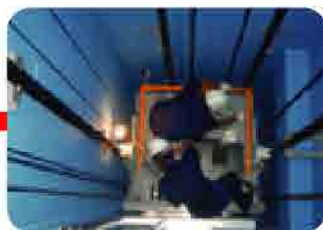
Kiểm tra hệ thống cơ khí và vệ sinh
